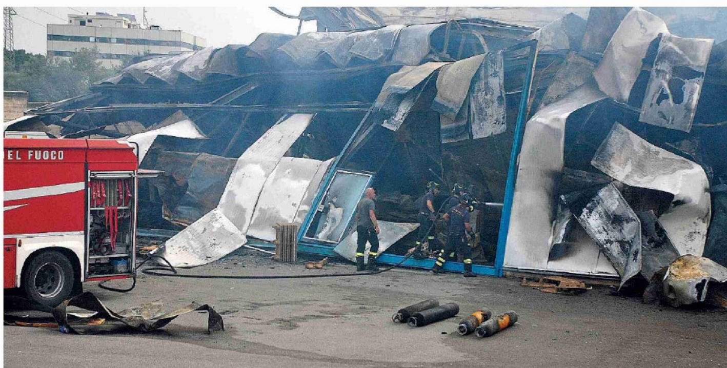
Il capannone di via La Malfa. La struttura distrutta dalle fiamme FOTO FUCARINI
