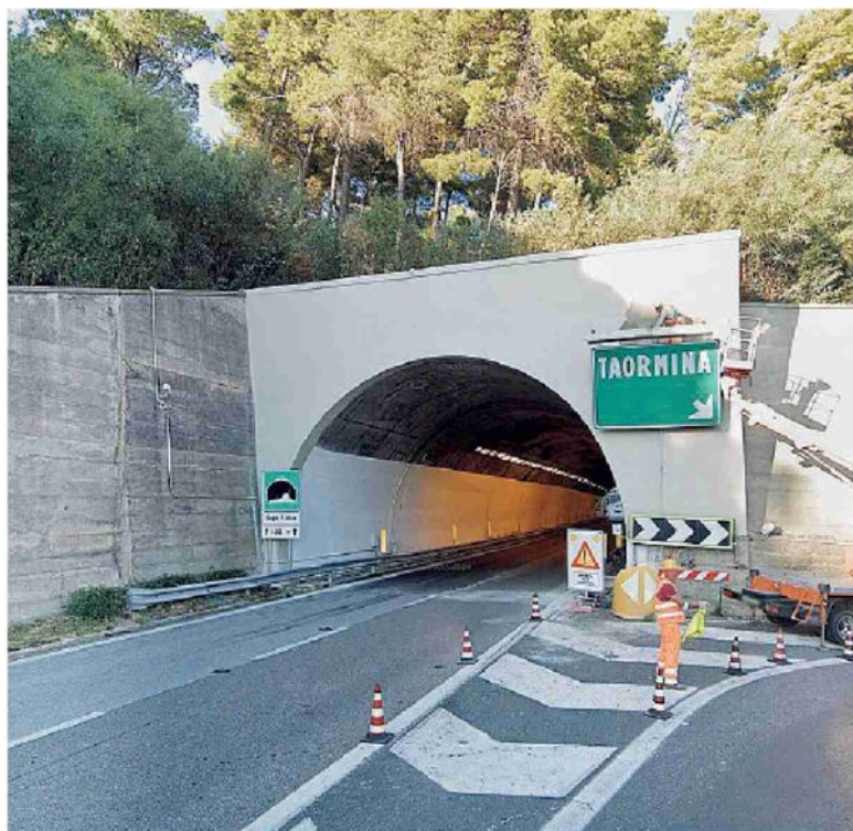
Messina-Catania. Martedì al via i lavori dedicati alla galleria Capo Pietra
