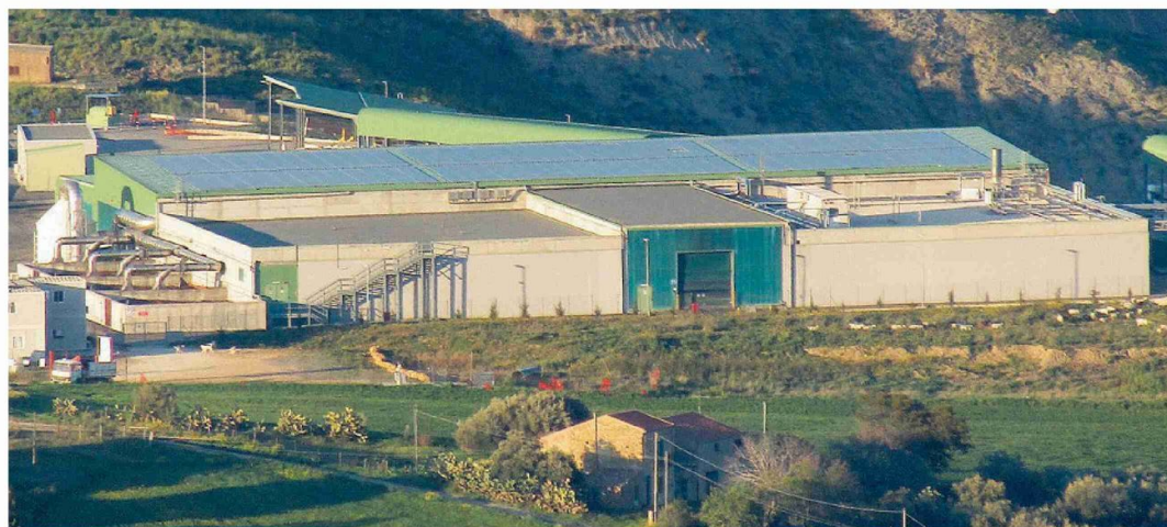
Qui sopra una panoramica dell'impianto di Tmb del sito di Cozzo Vuturo; in basso la discarica di Siculiana, nell'Agrigentino
