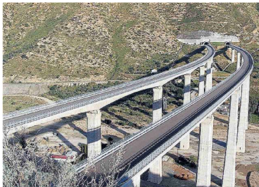
Un cavalcavia della Messina-Palermo: la Procura di Barcellona ha chiesto e ottenuto il sequestro preventivo di 22 attraversamenti a rischio crollo lungo l’A20. Quattro le persone denunciate
