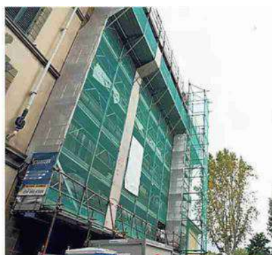
Un cantiere edile a Palermo
