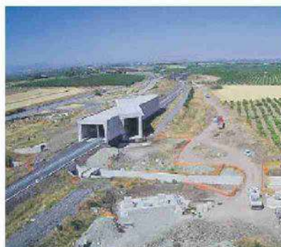
Cantiere della Bicocca-Catenanuova
