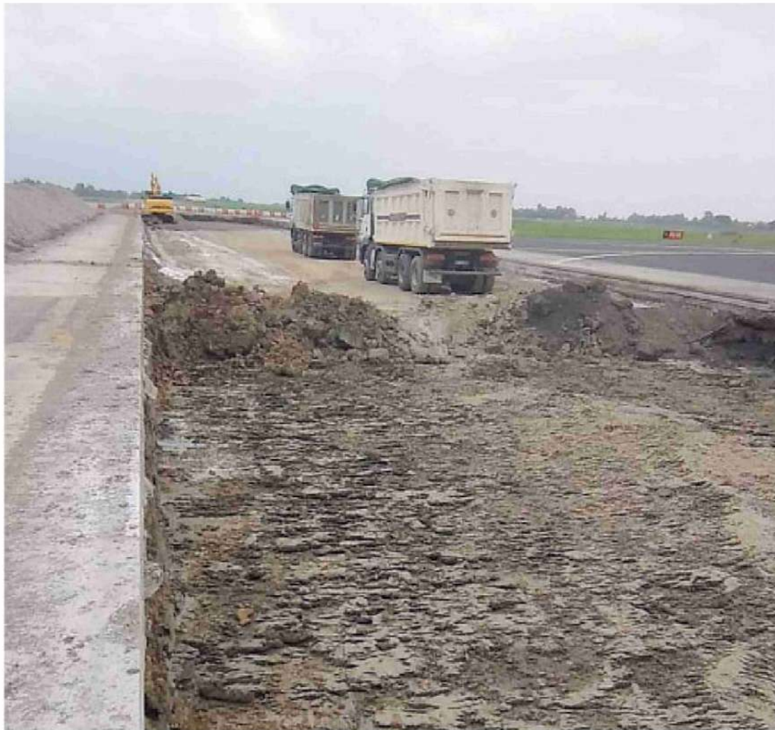
Il cantiere della nuova via di rullaggio degli aerei del “Vincenzo Bellini”
