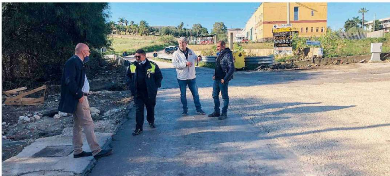
Sopralluogo nelle zone maggiormente alluvionate
