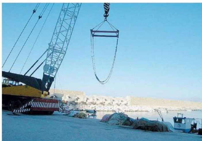
Il porto. Uno dei cantieri impegnati negli anni passati nei lavori
