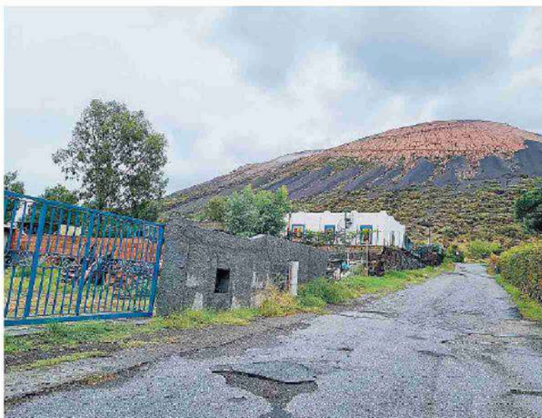
L'allarme. Le villette evacuate a causa del gas. (*FOTO BL*)
