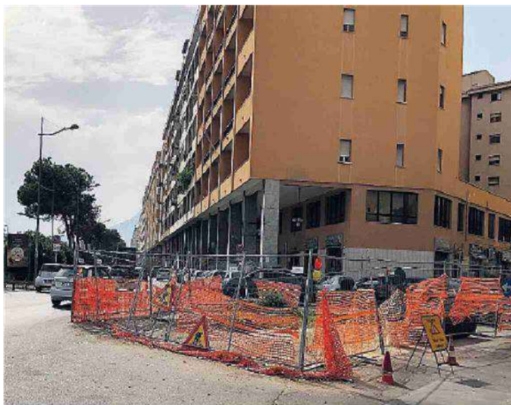
Corso Scinà. Il nuovo cantiere per il collettore fognario FOTO GILE
